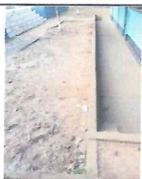
Foto 6: La escuela no cuenta con cuneta de salida de agua, lo cuál provoca inundaciones en los salones de clase en época de invierno.
